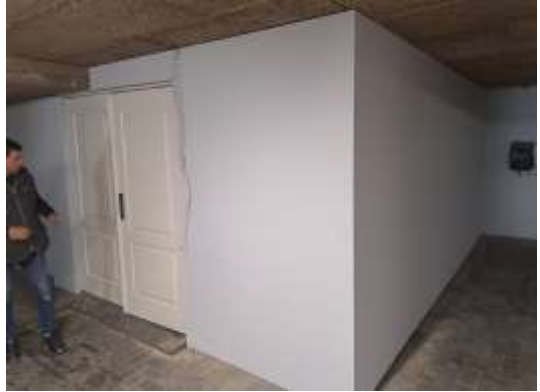
De vernieuwde houten buitenwand
